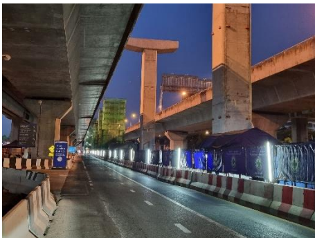
การติดตั้งไฟฟ้าส่องสว่างตามแนวพื้นที่ก่อสร้างเพิ่มเติม บริเวณช่วงทางวิ่งสถานี MT-01 ถึงสถานี MT-02
