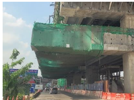
การติดตั้งตาข่ายเพื่อป้องกันฝุ่นละอองและวัสดุตกหล่น บริเวณสถานี MT-02
