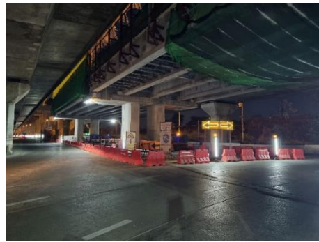
การติดตั้งไฟฟ้าส่องสว่างตามแนวพื้นที่ก่อสร้าง และเพิ่มสปอตไลท์บริเวณใต้สถานี MT-01
