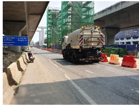
การใช้รถกวาดตูดฝุ่นทำความสะอาดถนนสาธารณะ บริเวณช่วงทางวิ่งสถานี MT-01 ถึงสถานี MT-02
