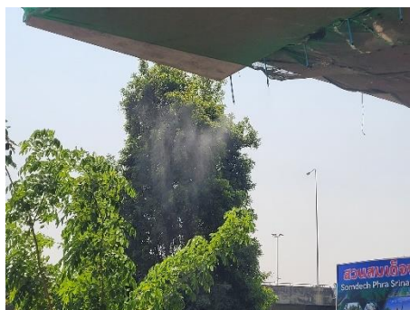
การติดตั้งเครื่องฉีดพ่นละอองน้ำบริเวณพื้นที่ก่อสร้าง บริเวณสถานี MT-02
